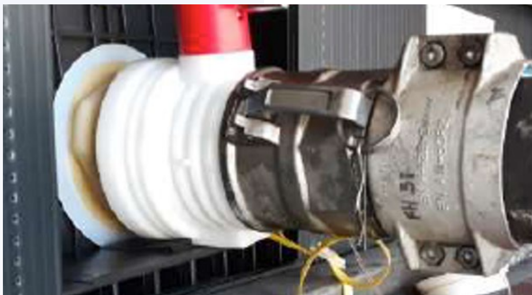
Válvula de llenado/descarga - Filling/discharge valve
