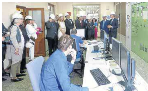
En la sala de control de la electrólisis.
