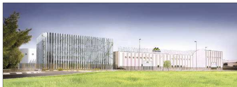
Simulación de nuestras futuras oficinas (actualmente en construcción) junto a nuestro principal centro de producción en Villena
