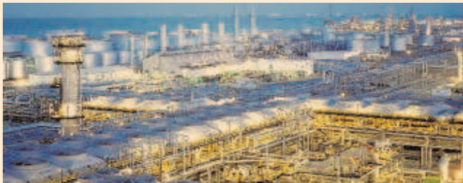
Instalaciones de la petrolera nacional saudí (Aramco)
