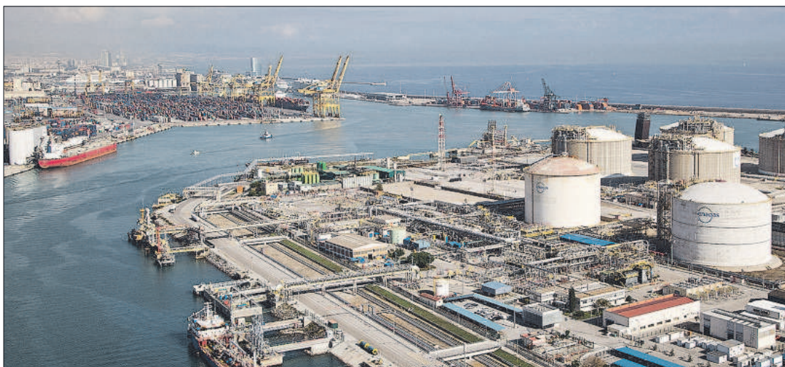
La planta de Enagas en el Port de Barcelona suministrará gas natural licuado a gabarras y barcos pequeños
