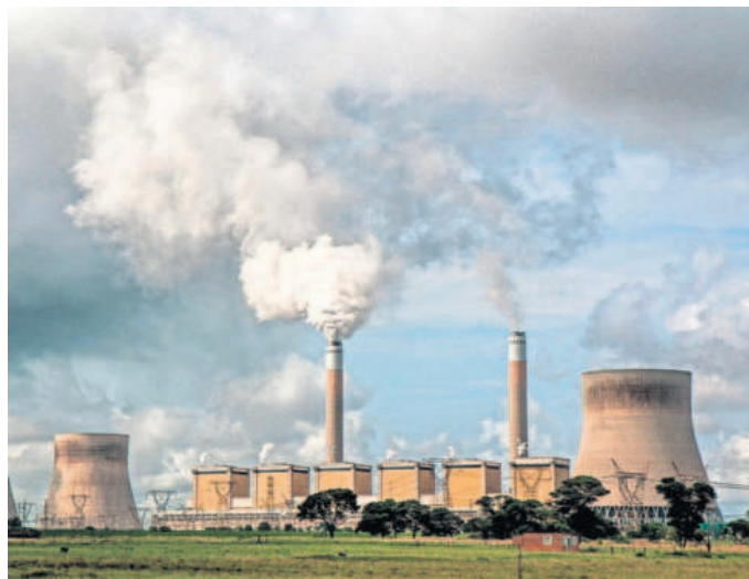
Una central eléctrica en funcionamiento. PIXABAY
