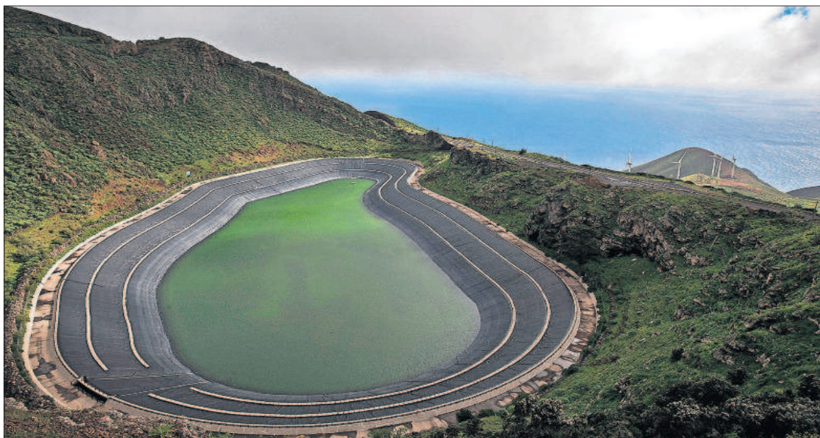
Depósito superior de agua de la central de Gorona del Viento en la isla de El Hierro. / CARLOS ROSILLO
