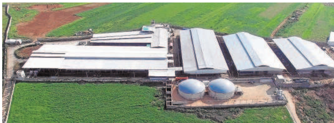
Explotación lechera, con el digestor y el posdigestor de forma circular en primer término
